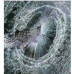
▲ハンマーで叩いても、亀裂は入りませんが、ガラスは脱落しません。
